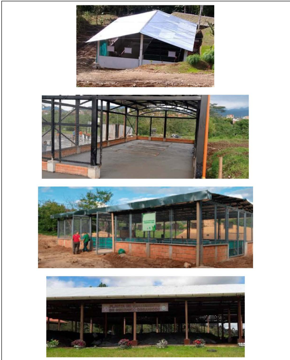
Figura 9A. Ejemplos de estructuras de biofábricas o plantas procesadoras de compost sólido y otros bioinsumos.
